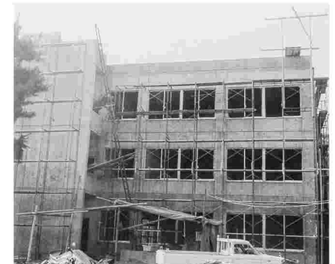
熊野商工会館着工
